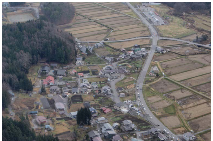
ヘリによる上空視察① 住家被害の状況 【白馬村内】
