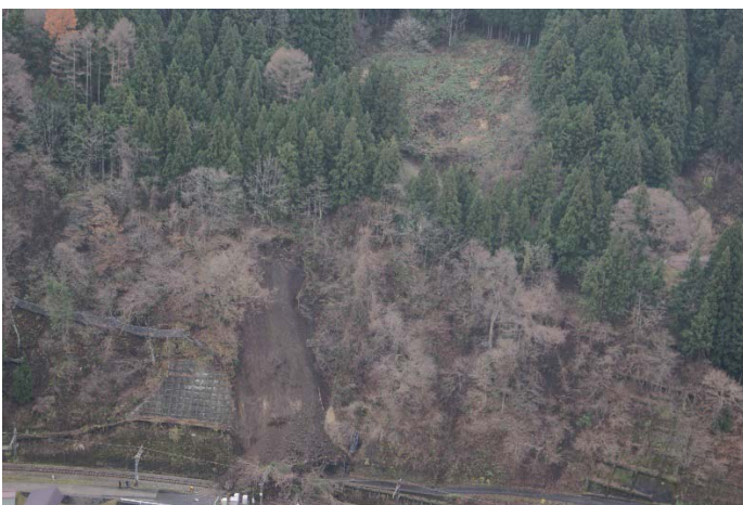
ヘリによる上空視察② 崖崩れによる大系線および国道148号の被災状況 【小谷村内】
