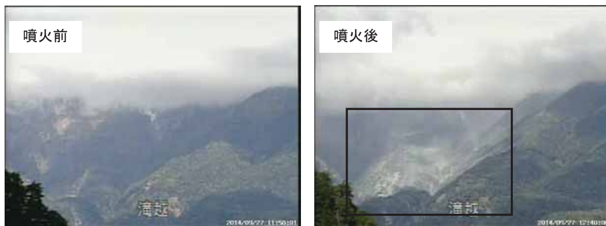
第 3 図 御嶽山 噴火発生前後の状況 (2014 年 9 月 27 日 11 時 50 分と 12 時 40 分の比較) (中部地方整備局設置の滝越カメラによる) ・山の南西側斜面を火砕流が 3 km を超えて流下した。右図四角枠内に火砕流が堆積している。
