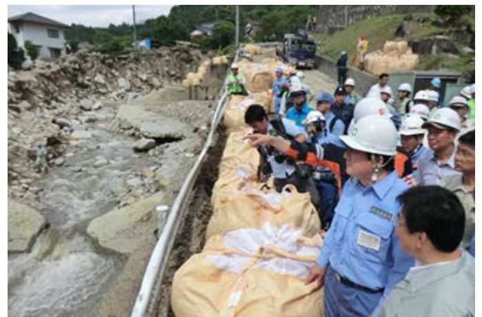
土嚢を積んだ応急措置 【長野県木曾郡南木曾町読書地区】
