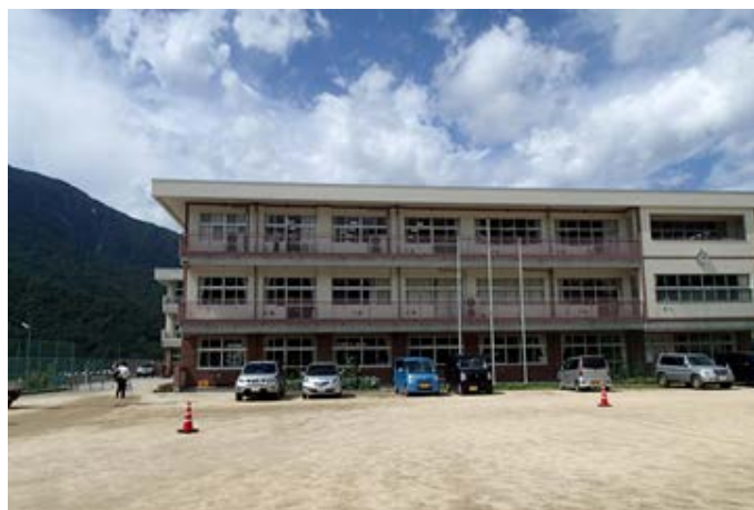
避難所の様子 【南木曾小学校】
