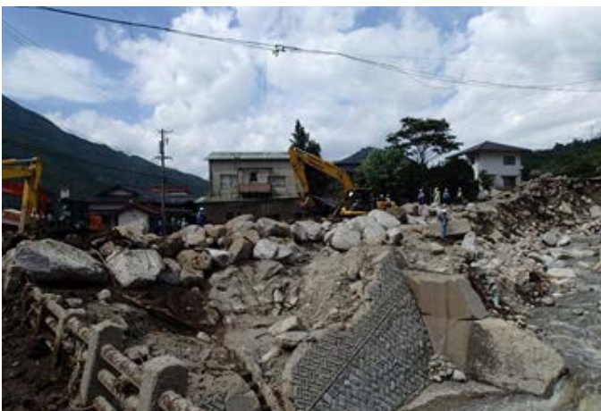
土石流除去作業の様子 【長野県木曾郡南木曾町読書地区】
