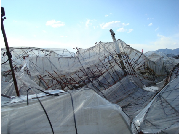
倒壊したビニールハウス 【甲州市塩山地区】
