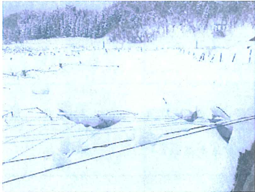
ぶどう棚が雪で埋没し一部損壊した様子 【横手市山内大沢地区】
