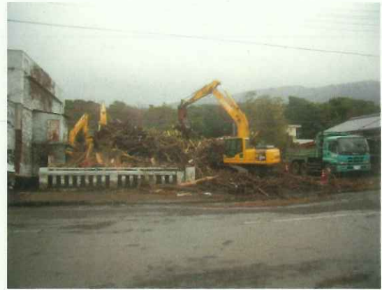
⑭土砂や瓦礫を撤去中の様子 【元町3丁目】
