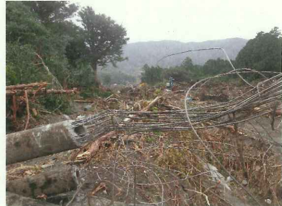
⑩倒壊した電柱被害の様子 【元町丸塚地区】
