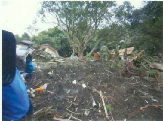
⑨土石流による土砂・流木で埋まった住宅 【元町丸塚地区】
