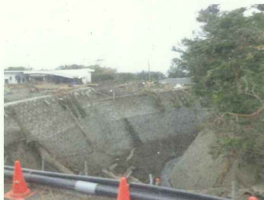
⑤土石流で氾濫した河川の様子 【元町丸塚地区】
