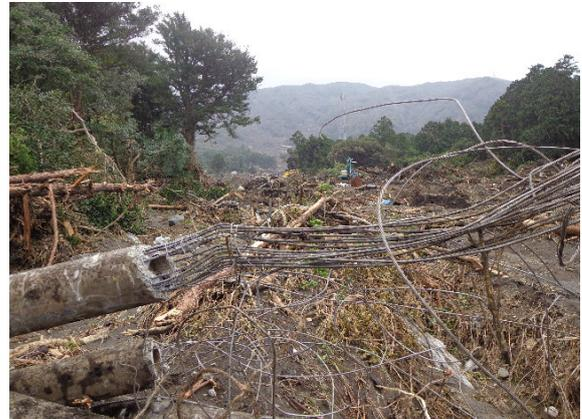
⑩倒壊した電柱被害の様子
