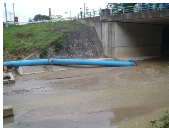
損壊した水管橋【岩手県矢巾町】
