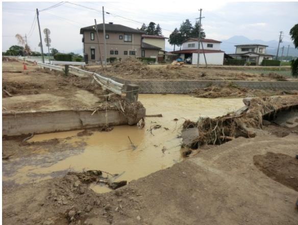
河川の氾濫による岩崎川橋の被害状況【岩手県 矢巾町】
