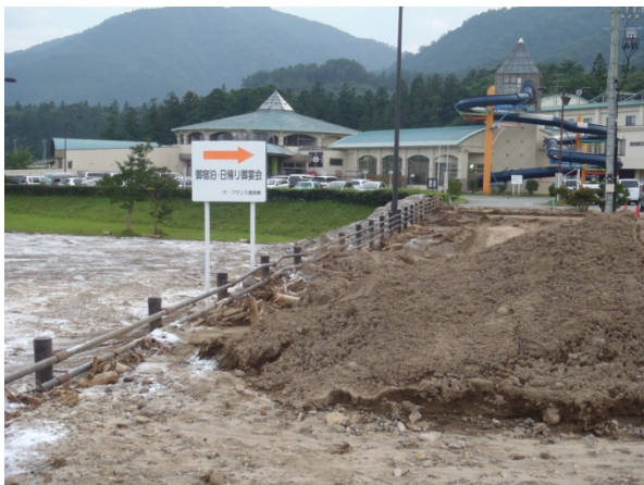
土砂流入の被害状況【岩手県紫波町ラ・フラン ス温泉】
