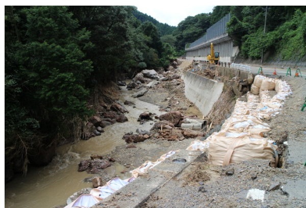
崩落した道路 【津和野町鷲原地区】
