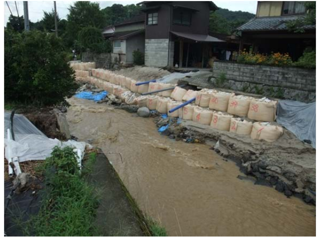
↑ 白木谷川被災地
