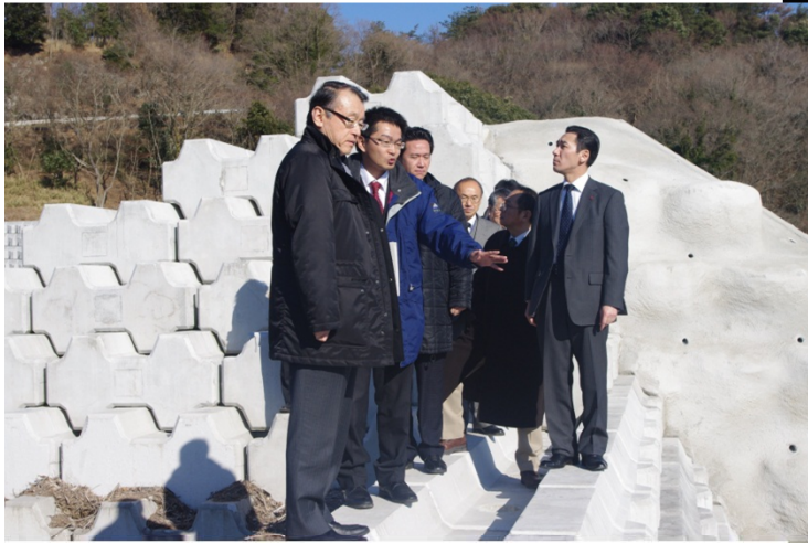
土石流対策施工現場において、新燃岳火山噴火に伴う火山灰による土石流対策について、大脇 国土交通省宮崎河川国道事務所長から事業概要等の説明を受ける中川大臣
