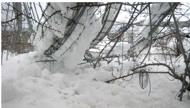
↑雪の重みで倒壊したパイプハウスの状況【寒河江市】
