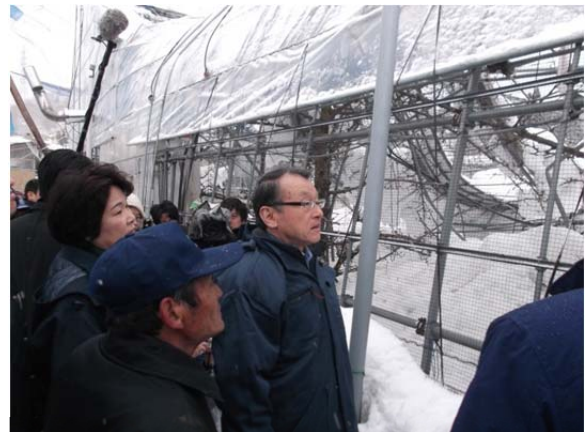
↑雪の重みでパイプハウスが倒壊している様子を調査【寒河江市】
