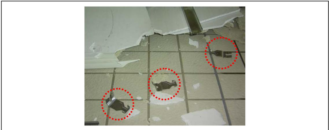
○ 図7 壁面に残る野縁受けの衝突跡
