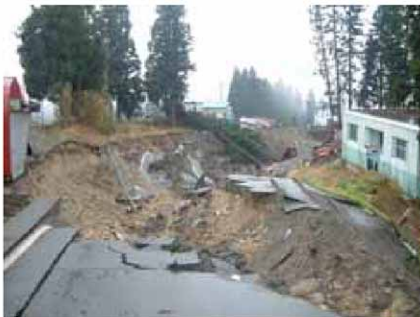
地滑りにより流出した塩殿浄水場
