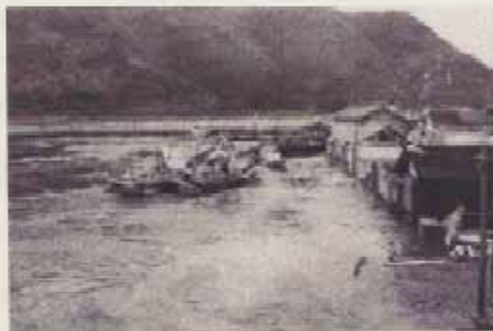
須崎市・チリ地震津波による被害 (須崎市提供)
