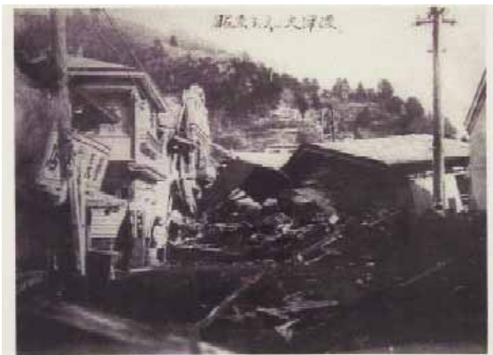
昭和三陸地震津波(昭和8年) 津波により建物が倒壊、道路ががれきで埋まる
