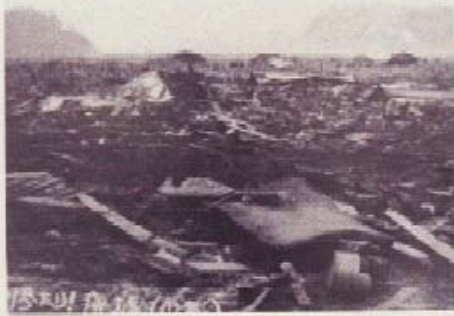
田老町・昭和三陸津波による被害 (田老町提供)
