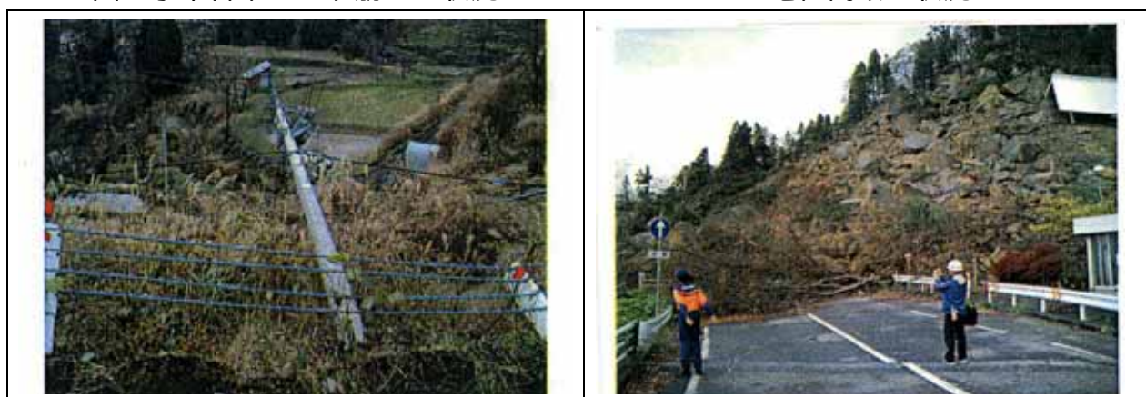
図：山古志村の道路崩壊に伴う 電柱倒壊の状況
