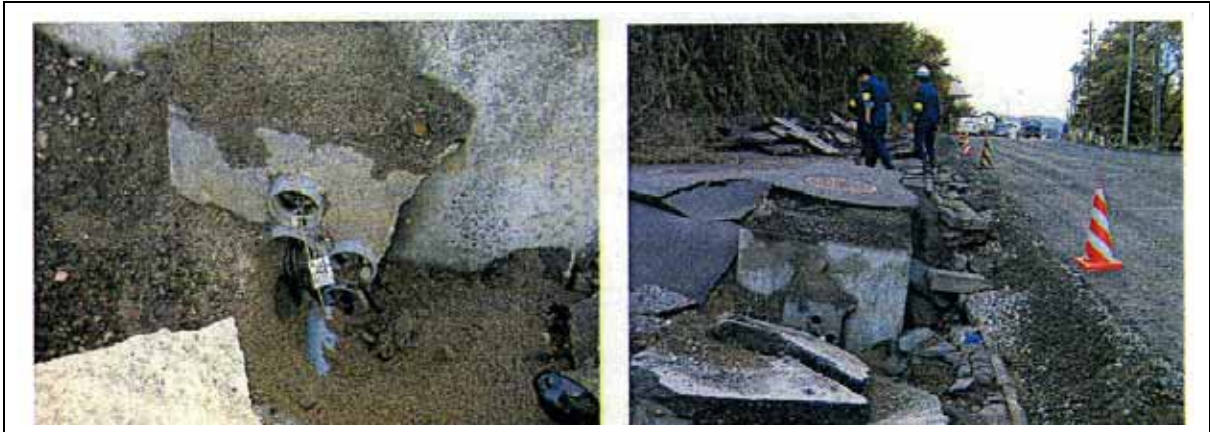
図：NTT東日本の地下管路の被害例
