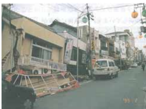
1階間口の耐力壁不足による倒壊
