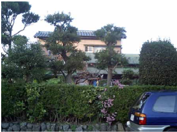
<平塚：公開耐震補強工事>
