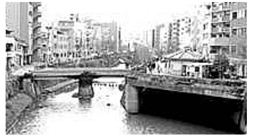
右岸バイパス水路の分流口
