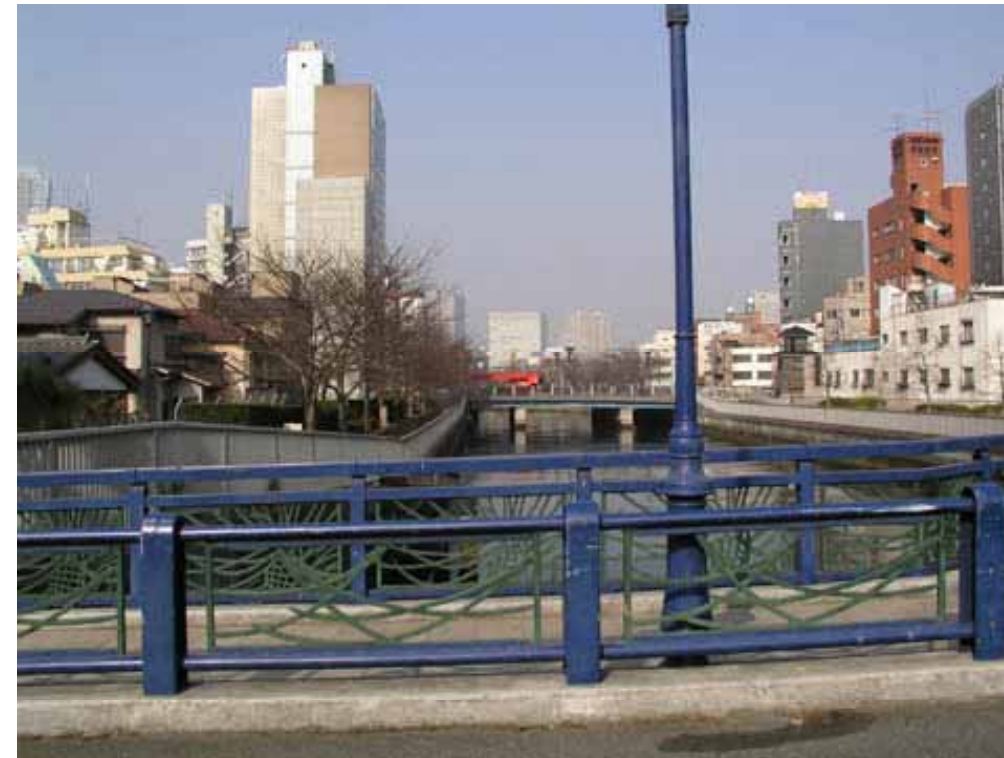
写真 2-4-6 両岸にテラス状の散策路がある大横川（左は通行可、右は立ち入り禁止）
