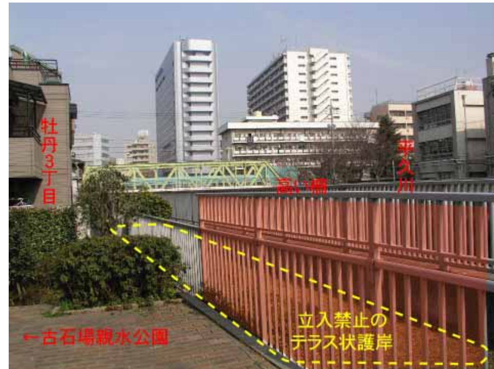
写真 2-4-16 テラス状護岸の歩道整備と古石場親水公園の接続
