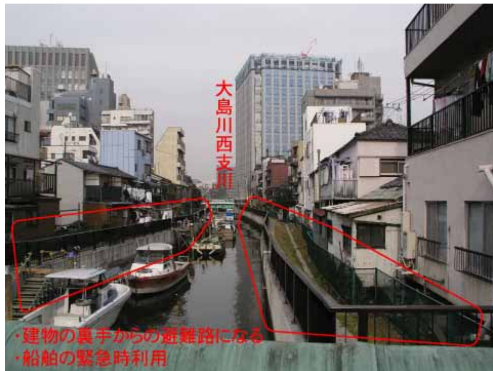
写真 2-4-15 建物の裏手にあって立入できない護岸の活用
