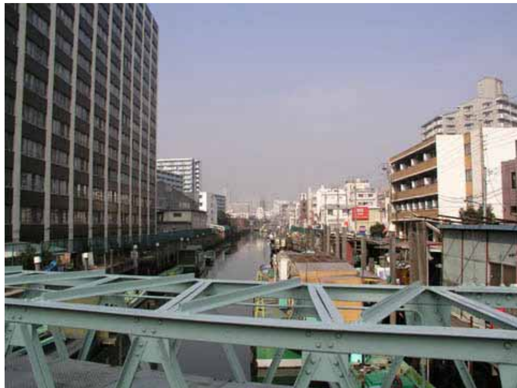
写真 2-4-10 多くの船が係留されている越中島川
