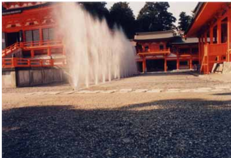
写真 - 2.5.2 散水設備の事例
