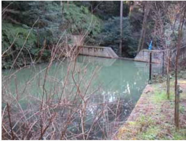
写真 - 1.5.1 既設砂防ダム（菊谷川）
