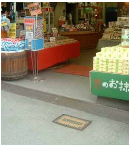
清水坂の消火栓
