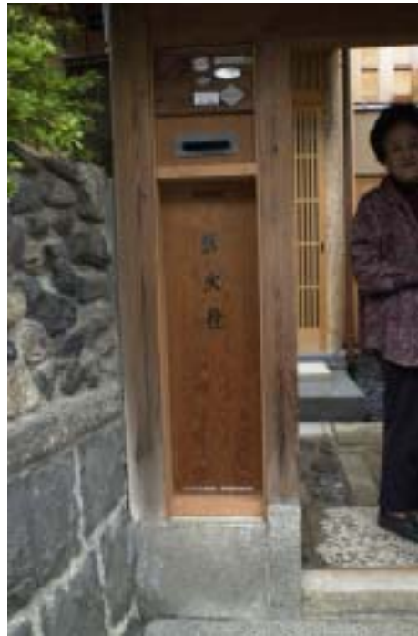
民家の玄関脇にさりげなく設置してある 消火栓
