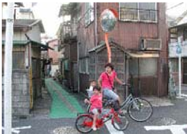
延焼の危険性が高い路地
