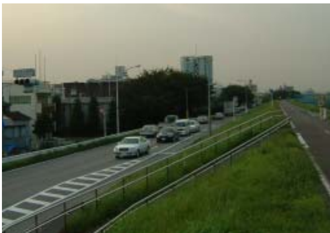
金町浄水場 (江戸川右岸堤防から望む)
