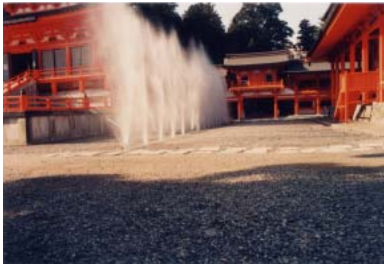
写真 - 5.2 散水設備の事例
