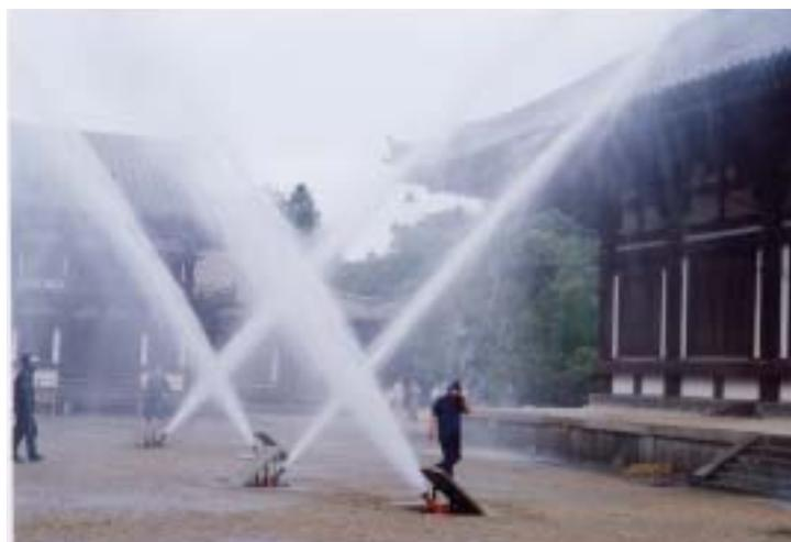
写真 - 5.2 散水設備の散水状況
