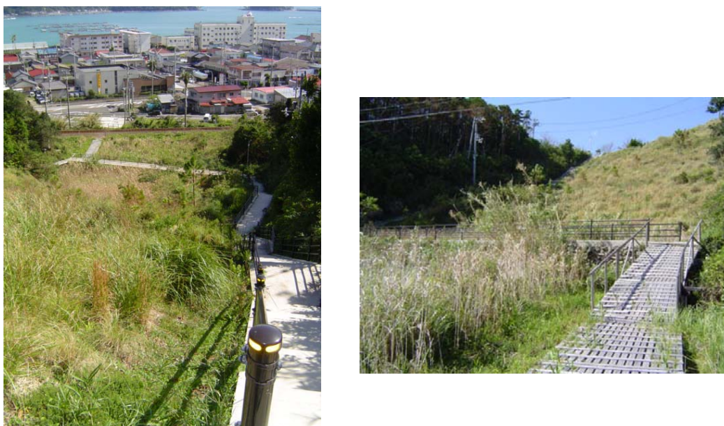
図 1 高台への避難階段・通路と避難場所（和歌山県串本町）
