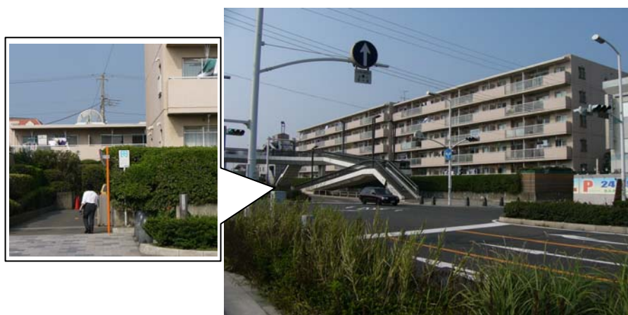
図 2 藤沢市における津波避難ビル（民間マンション）
