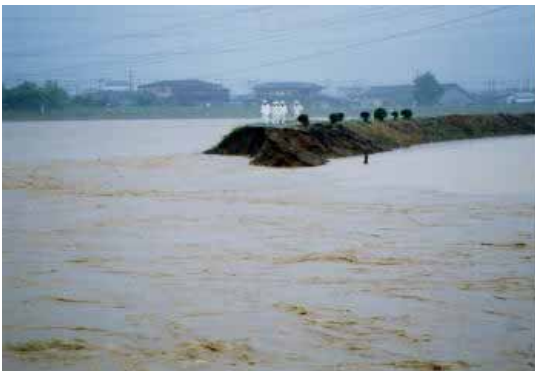
五十嵐川右岸破堤部：7月14日三条市撮影
