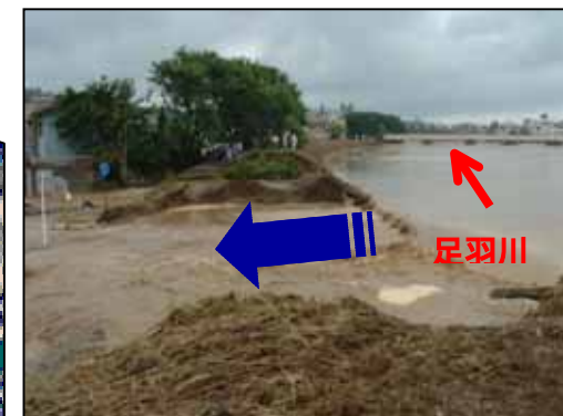
足羽川左岸破堤部：7月18日撮影
