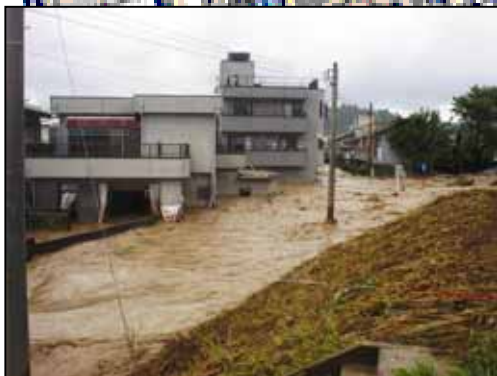
足羽川左岸破堤箇所付近：7月18日撮影
