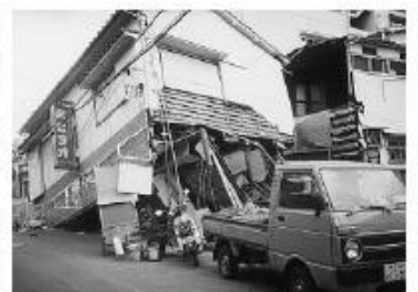
▲阪神・淡路大震災で倒壊した建物
