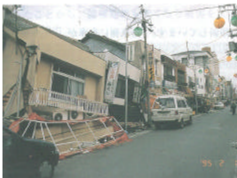
1階間口の耐力壁不足による倒壊
