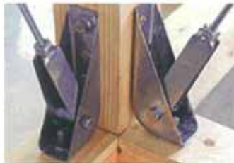
<コボット・ステンブレース取付例>
