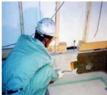
プライマー塗布
