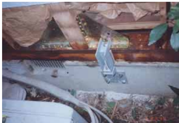
建物の足元補強(柱脚部分の補強) ML 金物、AR 金物を使った補強の例
