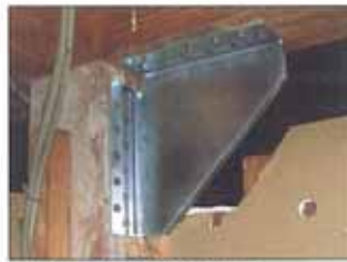
仕口ダンパー取付施工写真
