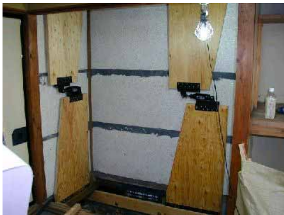
H邸(藤枝市)内壁取付け写真
