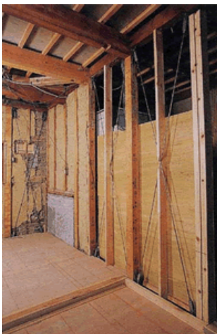
古い土壁も内側をはがすだけで補強できます。
