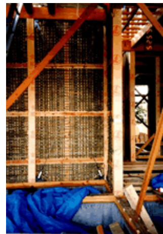
土壁内部に取付けられた壁用ステンブレース・システム
