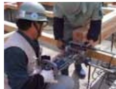
鉄筋挿入孔を穿孔
