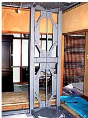
不動震設置工事壁(ブレース)組立完成事例
