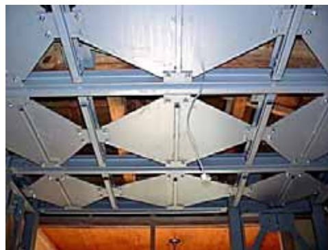
不動震設置工事天井組立完成事例
