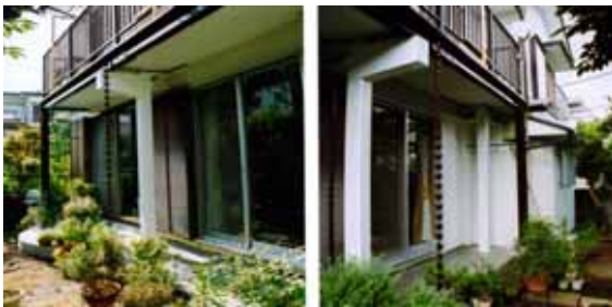
外部耐震補強構法の概念図
