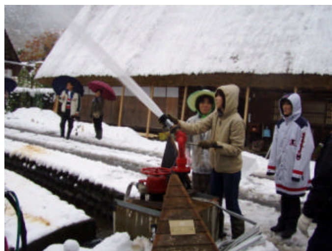
消火栓付き放水銃の整備 (岐阜県白川村萩町伝統的建造物群保存地区)
