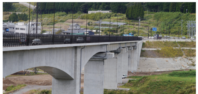
令和3年3月に開通した新阿蘇大橋と令和2年8月に復旧したJR豊肥本線
