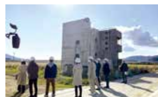
かさ上げ前の地盤に唯一残る“震災遺構” 「米沢商会ビル」（陸前高田市）
