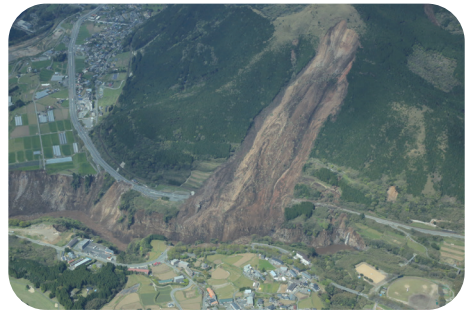
熊本地震による大規模山腹崩壊と落橋した阿蘇大橋（国土地理院撮影）
