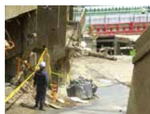
立入制限区域の規制の様子
