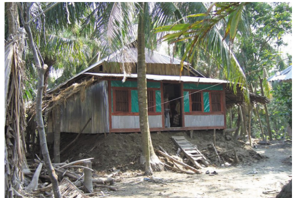
■サイクロンにより倒壊せずに残った住宅(土台に盛土の例)
