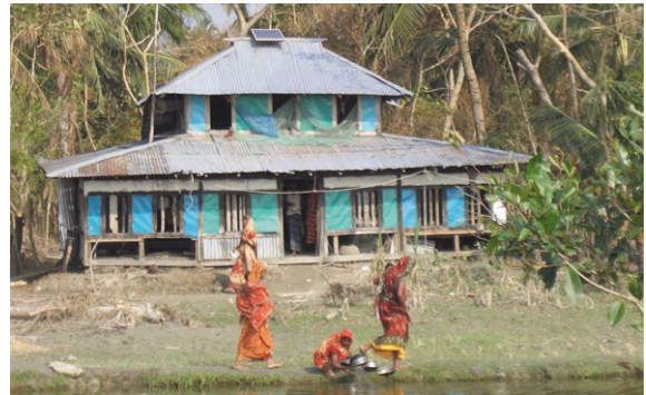
■サイクロンにより倒壊せずに残った住宅(土台がピロティ式)
