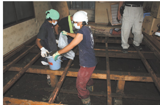
■浸水した家屋から土砂を運び出す作業のようす （平成19年9月秋雨前線による大雨の被害、北秋田市）
