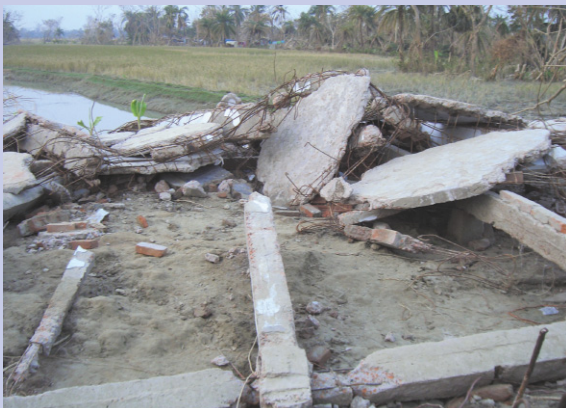
■破堤区域の堤内地にあって破壊された鉄筋コンクリートの学校
