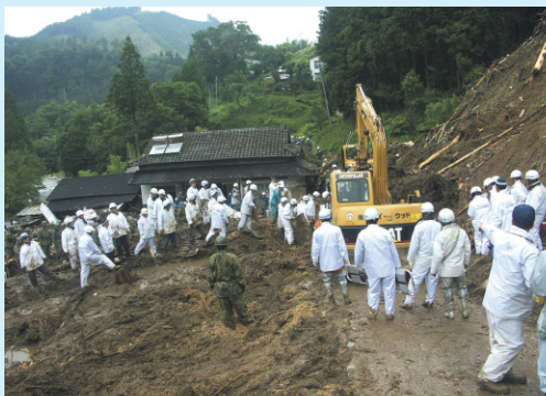
■大分県日田市の土砂災害現場での救助活動状況
