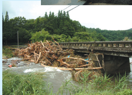
■上流のがけ崩れなどで流された木が橋にかかり 浸水被害を拡大 写真提供：大分県九重町
