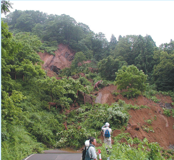
■県道大湯高柳線（上越市吉川区上川谷）の土砂崩落現場 写真提供：新潟県
