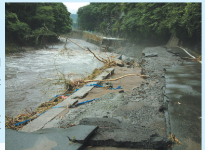
■崩落した県道
