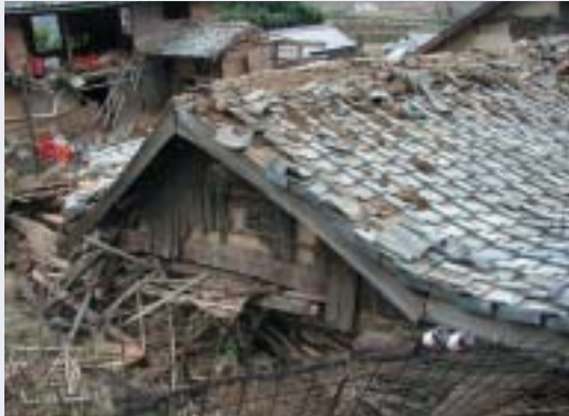
全壊した家屋：倉橋町 写真提供：広島県倉橋町
