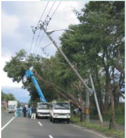
倒木と倒れた電柱の復旧作業
