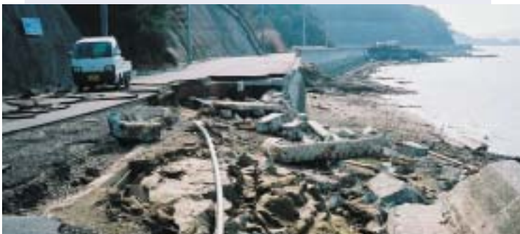
道路崩壊：安芸津町
