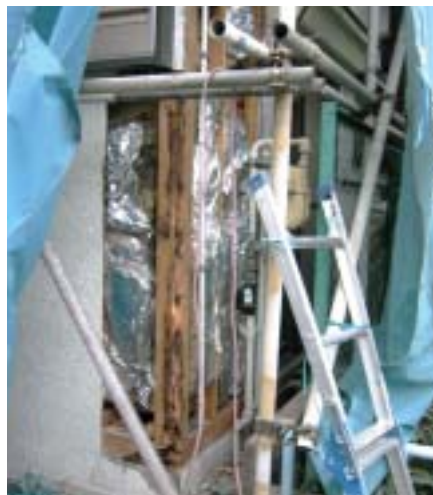
耐震診断の時はわからなくても、工事が始まってから老朽化に気がつくこともあります。
