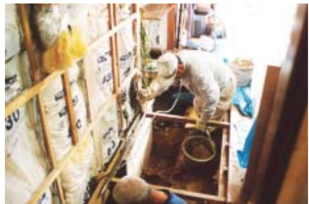
新しい壁で耐震補強するときは床や天井を剥がして行う工事が一般的です。
