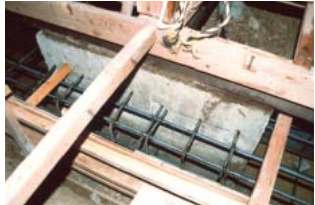
基礎が弱い場合には、床を剥がして基礎を増設するような工事をします。
