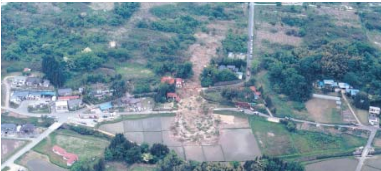
高速土砂流動が起きた宮城県築館町
