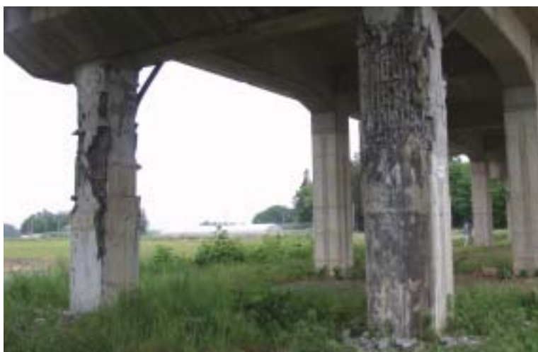
高架橋コンクリート破損状況(岩手県石鳥谷町) 写真提供：JR東日本盛岡支社
