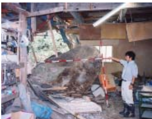
落石のあった宮城県栗駒町
