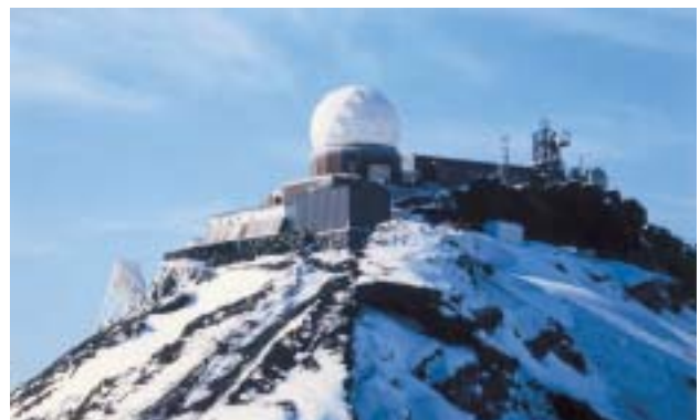
解体前の富士山測候所気象レーダー
