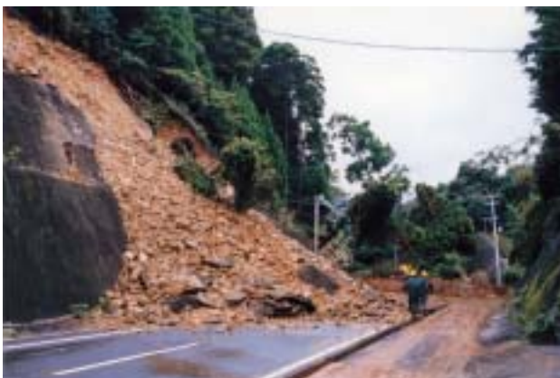
国道388号線の土砂崩れのため一時孤立状態となった（10月17日） 写真提供：宮崎県北浦町
