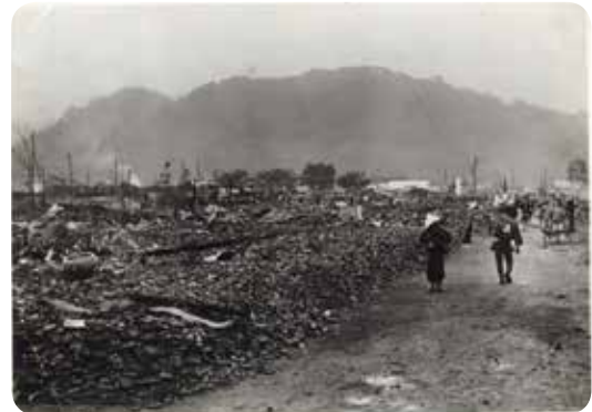
北但大震災によって町のほとんどが焼失した城崎温泉。(写真提供：豊岡市)
