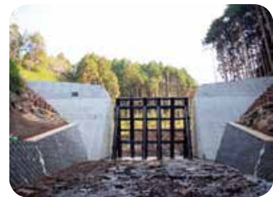
流木捕捉効果の高い透過型砂防堰堤(えんてい)
