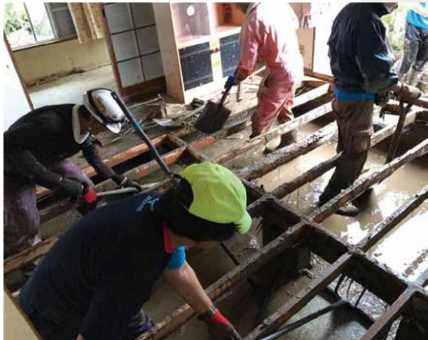
床下からの土砂出し(日田市)(写真提供:愛知人)
