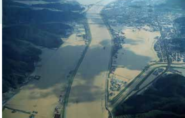
台風第23号により破堤した円山川(写真提供:国土交通省 豊岡河川国道事務所)
