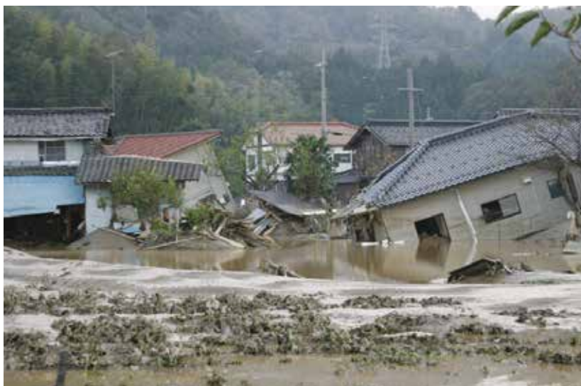
平成16年台風第23号による豊岡市出石町鳥居の堤防決壊現場
