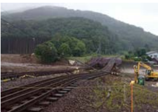
北海道新得町における鉄道被害の状況
