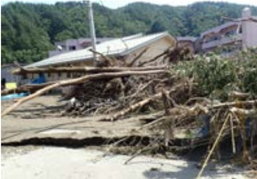
岩手県岩泉町のグループホームの被害状況
