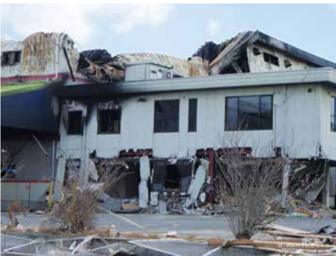
東日本大地震の津波で破壊された宮城県仙台市の工場 (消防科学総合センター 提供)
