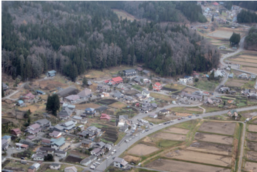
白馬村堀之内地区・被災後の航空写真
