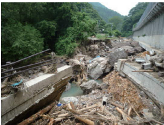
崩落した道路（島根県津和野町高峯地区）
