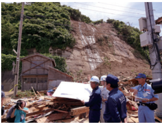
土砂崩れによる住家被害の状況（長岡市寺泊山田地区）
