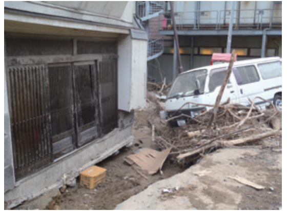
被害を受けた建物及び車両（岩手県盛岡市繋温泉）
