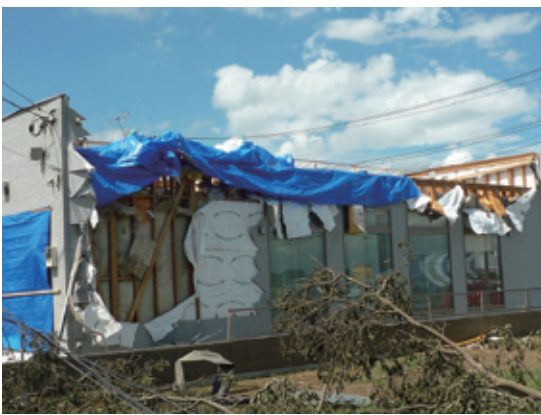
住宅街の被害の様子（埼玉県松伏町大川戸地区）
