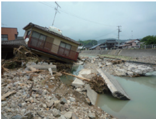
被害を受けた堤防及び住家（山口県萩市須佐地区）
