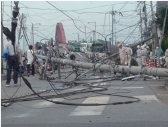
住宅街の被害状況（埼玉県越谷市大杉地区）
