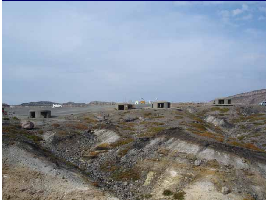
退避壕が火口周辺に設置
