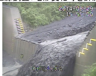
有村川における土石流観測
