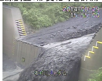
有村川における土石流観測
